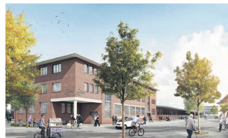
Das neue Domizil der Aurelis Region Nord: Harkortstraße 79 in der Mitte Altona.
