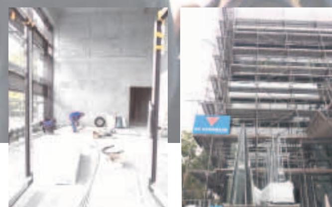
Hier entsteht die Eingangshalle im neuen Ingenieurwerk an der Georg-Wilhelm-Straße.
