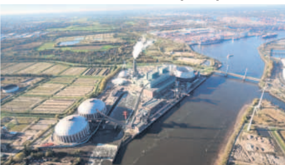
Sorgt für gute Zahlen beim Massengutumschlag im Hamburger Hafen: das Steinkohlekraftwerk in Moorburg. Foto: Vattenfall Lindner
