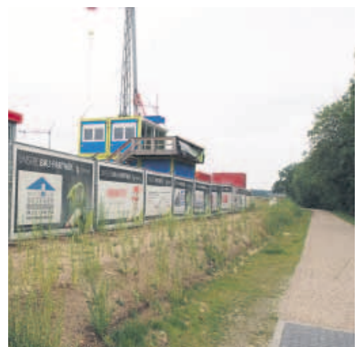
Der Ilmenau-Radwanderweg führt direkt zwischen Ufer und Baufäche entlang.
