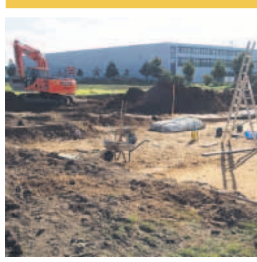
Diese „Großbaustelle“ im Buchholzer Gewerbegebiet Trelder Berg ist nicht etwa die Gründung eines neuen Firmensitzes, sondern eine Lehrgrabung, die Landkreisarchäologe Dr. Jochen Brandt derzeit unterhält. Foto: Wolfgang Becker
