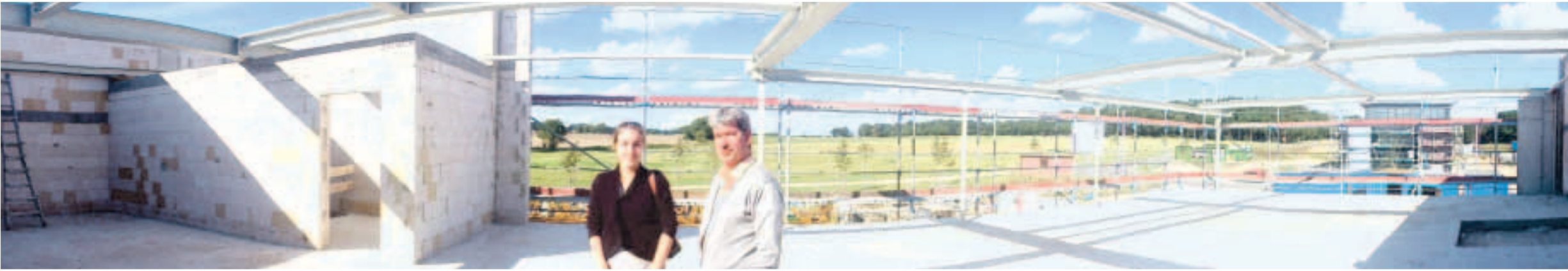
Baustellenbesuch mit Holger Grundt und seiner Tochter Isabelle, die mittlerweile als Assistentin der Geschäftsführung ins Unternehmen eingestiegen ist. Dieses Foto zeigt den Büro- und Schulungsbereich im ersten Stock.
