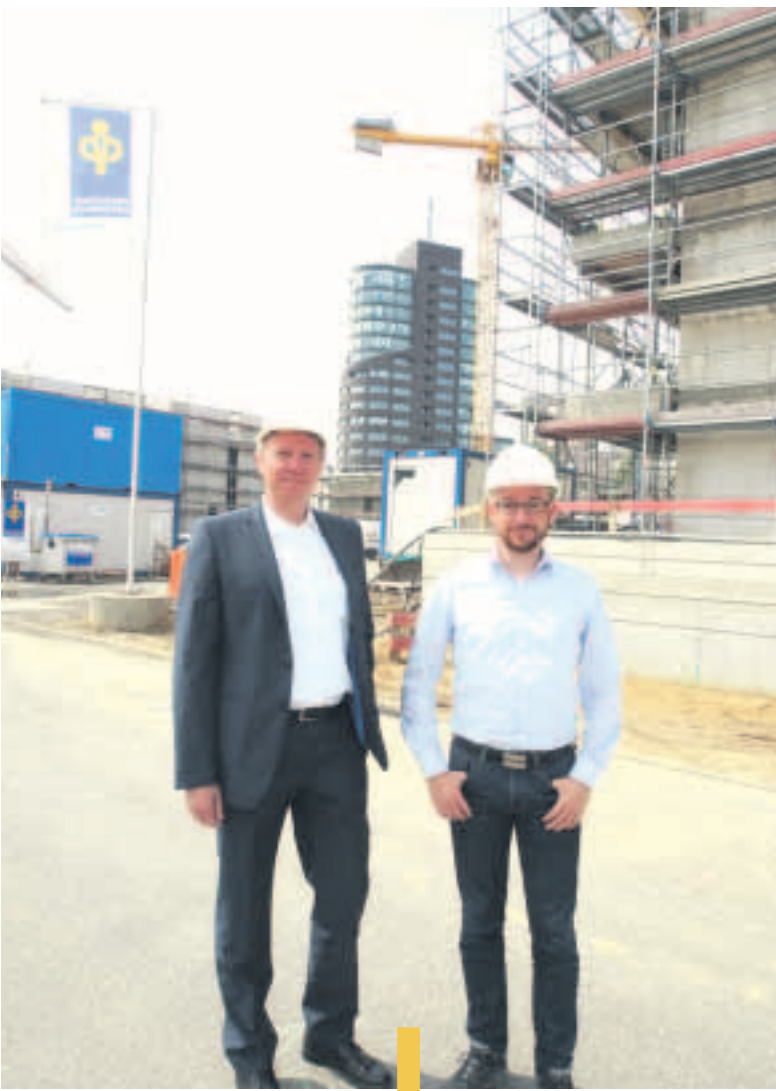
LINKS OBEN: Bis zum Richtfest ist es nur noch ein kleiner Schritt: Alexander Kuhlendahl (links) von REVITALIS und der Bauverantwortliche vor Ort, Daniel Averbeck von MPP, vor dem fast fertigen Rohbau der Phoenix Höfe im Harburger Binnenhafen. Foto: Wolfgang Becker
