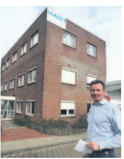
Geschäftsführer Rainer Kalbe beschäftigt mittlerweile 31 Mitarbeiter. Bereits seit Januar richten sie sich am neuen Standort ein. Auch die elektronische Steuerung der Haustechnik gehört zu seinem Metier.
