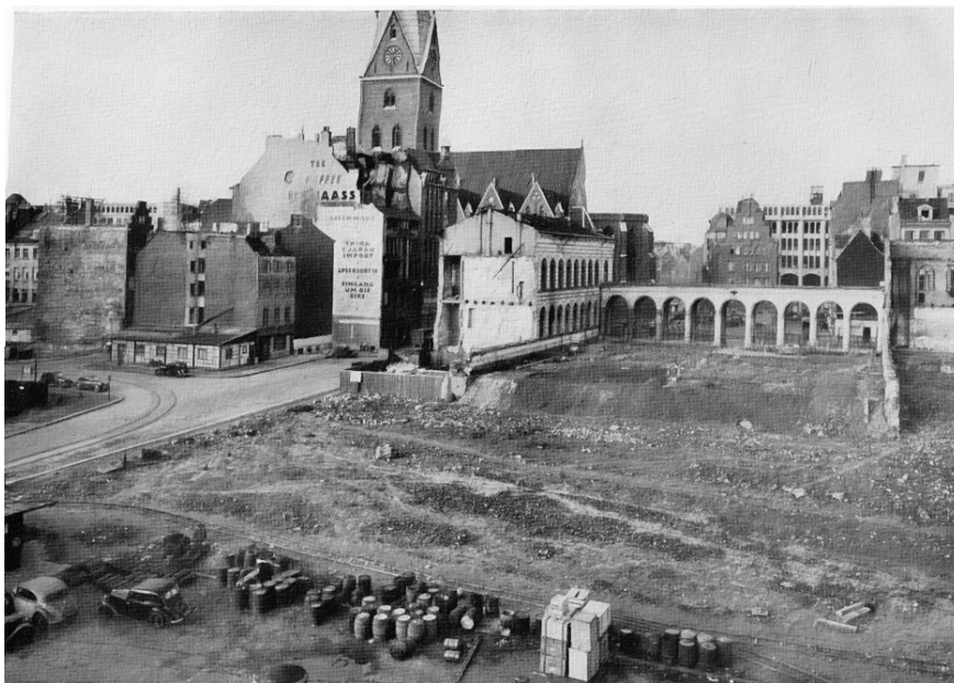
Abb. 10 Zustand des Johanneums nach den Trümmerräumarbeiten, 1949. Die erhalten gebliebenen Arkaden mit dem Rest des Westflügels wichen später der Straßenverbreiterung.
