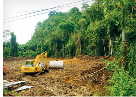
Baustopp in letzter Minute: Hier wurde bereits für Arbeiterquartiere gerodet
