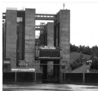
Schiffshebewerk, welches 1974 in Betrieb ging. In zwei Kammern wird ein Trog (mit Wasser und Schiff) 38 Meter hinauf oder hinab befördert. Das war schon sehr eindrucksvoll. Wir nutzten die Zeit für angeregte Gespräche an Deck oder im Innenbereich. Nach dem Anlegen in Lauenburg ging es auf dem gleichen Weg nach Bergedorf zurück wie am Vormittag. Wie gut, dass es immer es jemanden gibt der einen „Plan B“ hat.
