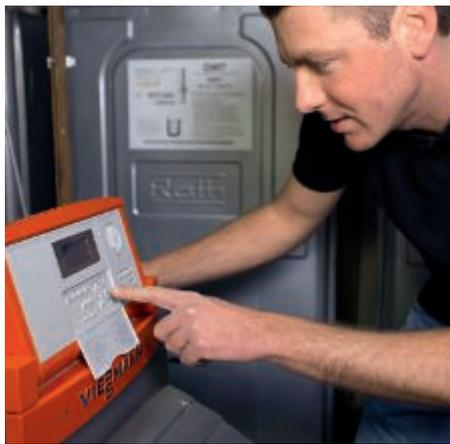
**Neues Herzstück:** Der Vitoladens 300-C von Viessmann ist ein modulierender Brenner – er passt seine Leistung dem aktuellen Bedarf an.
