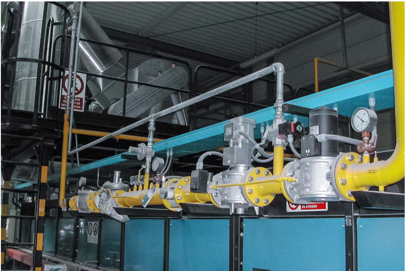
So wird die vollständige Gastrecke einer Thermoprozessanlage in der Industrie eingesetzt.
