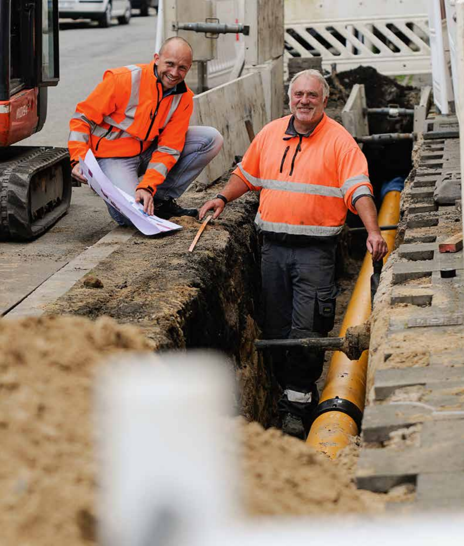
Hauke Krüger (l.) ist Chef der Firma Leitungsbau Nord aus Wankendorf. Er setzt in seiner Firma auf ein Wir-Gefühl seiner Mitarbeiter. Kommunikation und Transparenz sind für ihn zwei zentrale Elemente, um Fachkräfte langfristig binden zu können.
