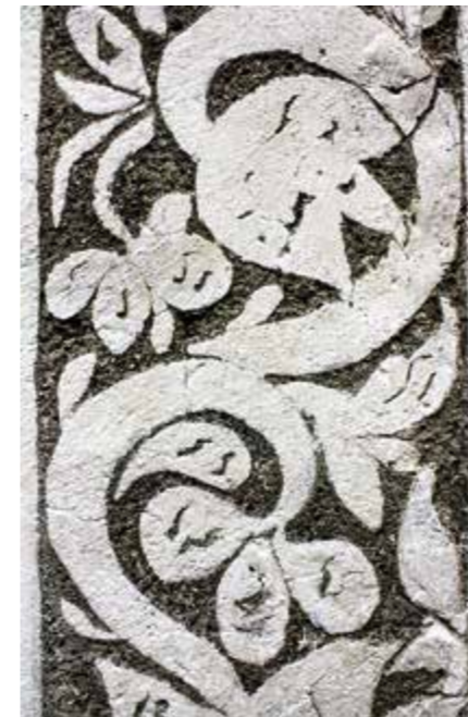
Zierde an Fachwerkhäusern: Der Kratzputz ist eine baugestalterische Tradition in Hessen.
