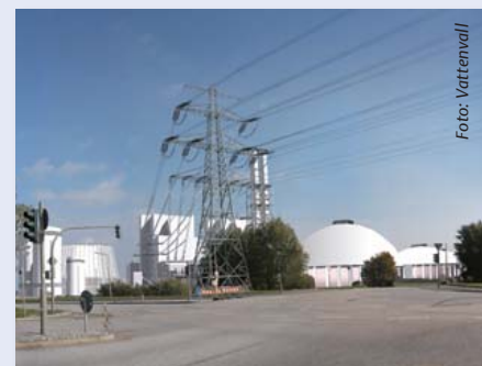
Das Steinkohlekraftwerk in Moorburg
