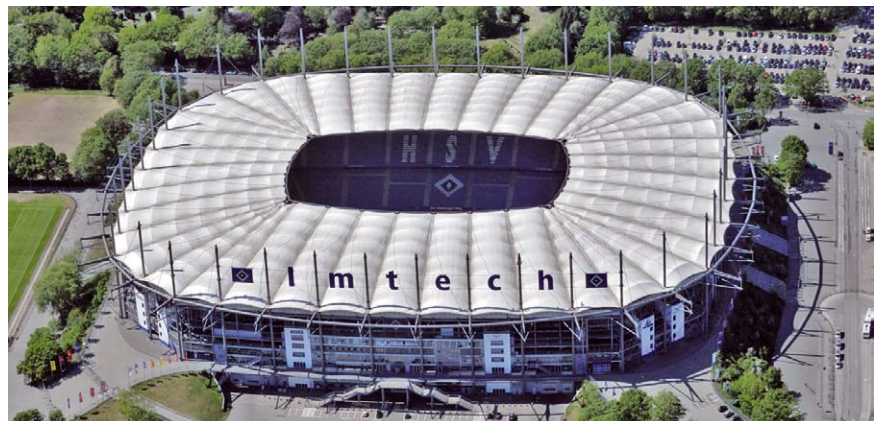
Imtech Arena in Hamburg - das Vorzeigeprojekt für Energieeffizienz
