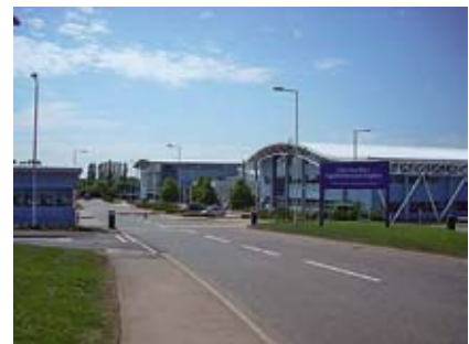
Das neue Produktionsgebäude von Mercedes-Benz High Performance Engines
