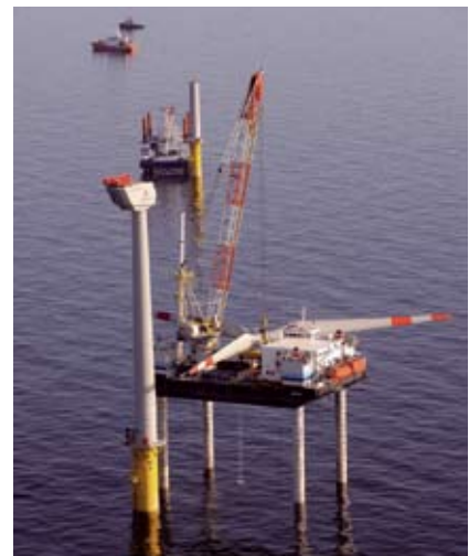
Bau einer Offshore-Windkraftanlage
