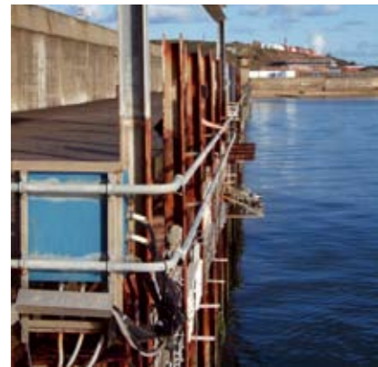
IWS-Versuchsstand an der Südwestmole im Vorhafen von Helgoland
