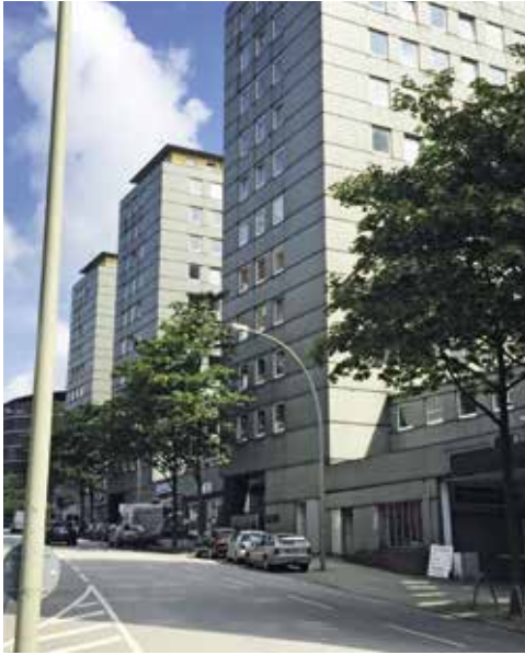
Gefährdete Nachkriegsmoderne: die City-Höfe
