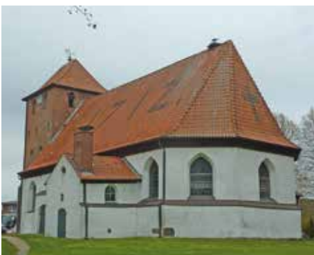
Im Storchendorf Bergenhusen muss auch das Kirchdach als Nistplatz für die Störche herhalten...
