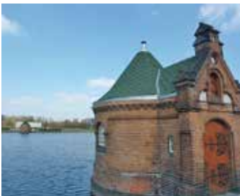
Wasserkunst mit Schieberhäuschen (Foto: dn)
