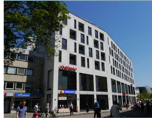
Die Fassade der "Bergspitze" zur Neuen Großen Bergstraße
