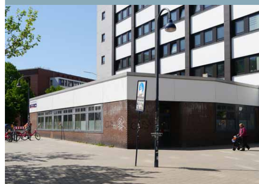
Die ehemalige Sparkassenfiliale soll für Einzelhandel genutzt werden
