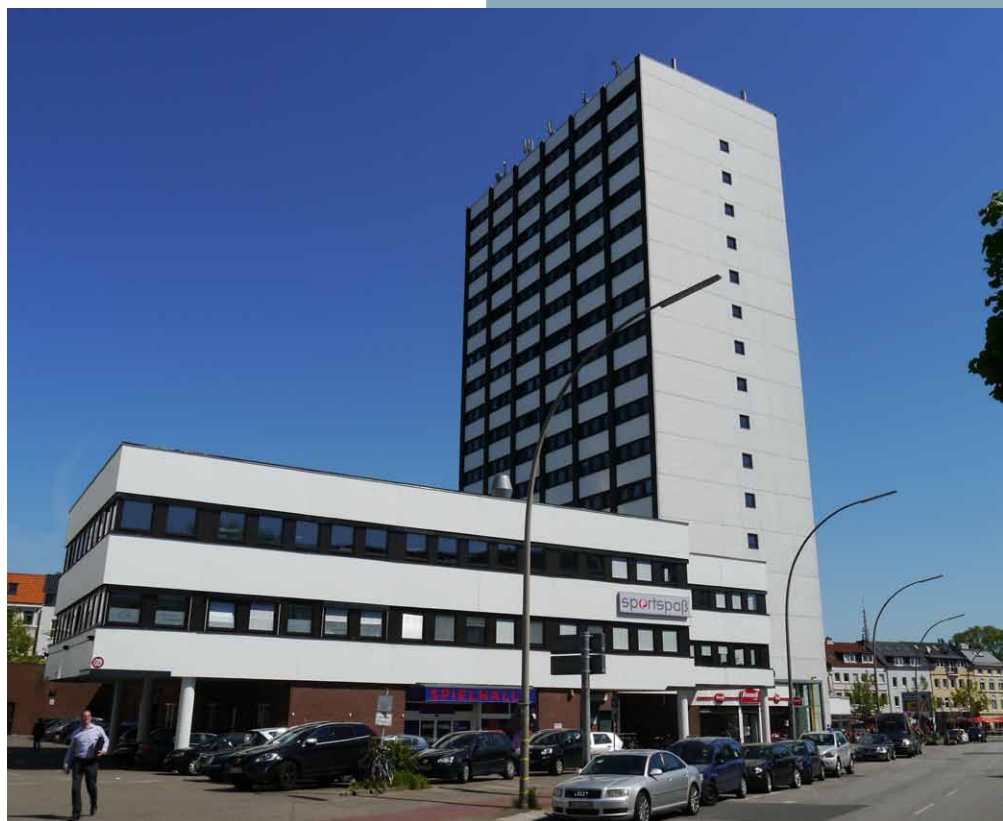
Die Fassaden des Büroturms und des Anbaus wurden saniert
