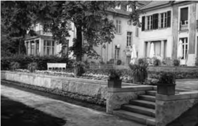
Rekonstruierte Stützmauer unter Verwendung originaler Steinblöcke
