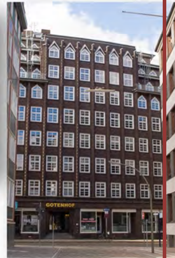
Dienstgebäude in Hamburg, Steckelhörn 12
