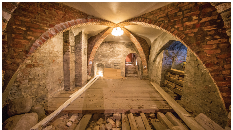
Der aktuelle Zustand des Harburger Schlossgewölbes. Foto: © André Zand-Vakili
