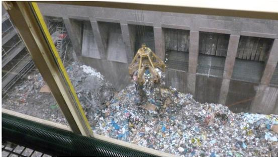
In zwei 30 m hohen Verbrennungsöfen wird der Müll der Stadt bei 850 Grad verbrannt und gleichzeitig Dampf für die Fernwärme erzeugt. Seit 1994 werden hier mittels der bewährten Technik der Rostfeuerung im Jahr mehr als 320.000 Tonnen Abfall aus den Hamburger Haushalten „rund um die Uhr“ verbrannt.
