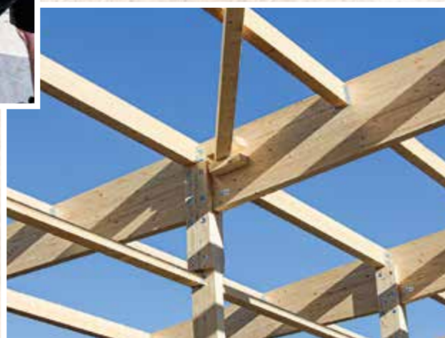
Einspannstützen mit Epoxidharz sind eine ansprechende Variante (oben). Die Tragwerkskonstruktion ist komplett aus Brettschichtholz gefertigt (Foto re.).
