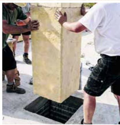
Einspannstützen mit Epoxidharz sind eine ansprechende Variante (oben). Die Tragwerkskonstruktion ist komplett aus Brettschichtholz gefertigt (Foto re.).
