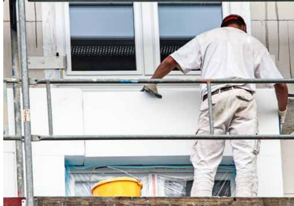
Gebäudedämmung ist ein wichtiger Beitrag, um den weltweiten Temperaturanstieg zu begrenzen. Doch die Investitionen in energetische Sanierungen sind in Deutschland zuletzt gesunken.
