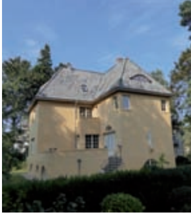
Detailgetreu renoviert: das Dehmelhaus
