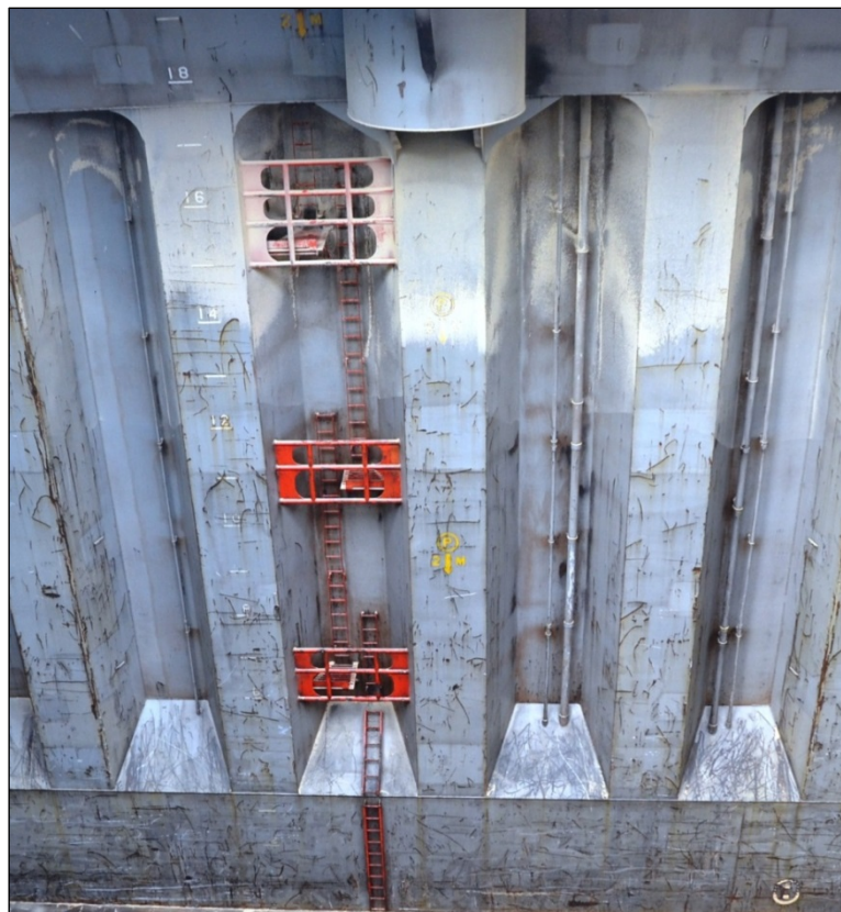
Abbildung 5: senkrechte Treppe an der Achterkante von LR3
