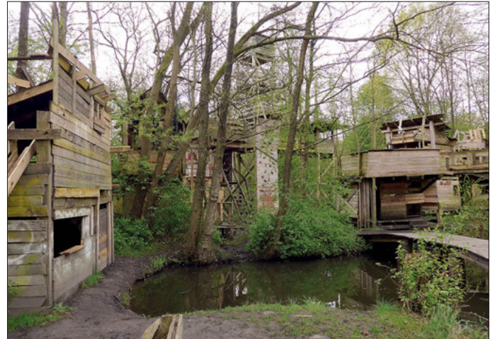
Von den Kindern gebastelte Holzkonstruktionen stehen rund um den Bauspielplatz.
