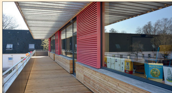
Über zwei Balkone können Personen im Notfall sofort ins Freie kommen.
