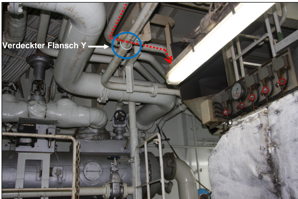
Abbildung 9: Verlauf des Abflussrohres (Nahaufnahme C)
