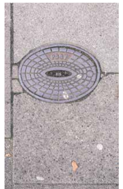
Solche „Briefbomben“ (links) flitzten durch Rohre unter der Altstadt. Über Öffnungen (rechts) konnte man Kondenswasser aus der Anlage entfernen
