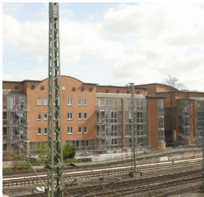
Von vhw an die Vonovia verkaufte Gebäude
