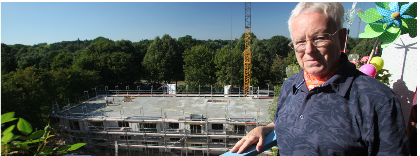
Rund um die Uhr lärmern die Baumaschinen, eine Belästigung, an die man sich nicht gewöhnen kann, sagt Mieterin Monika Lühr.
