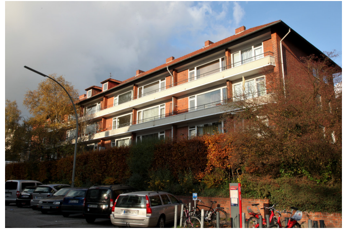
Eppendorfer Weg: Die Wohnanlage im Herbst 2014 kurz vor Beginn der Dachaufstockung.
