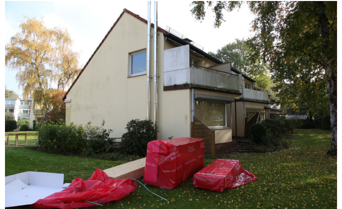
OSB-Holzplatten vor den Häusern.
