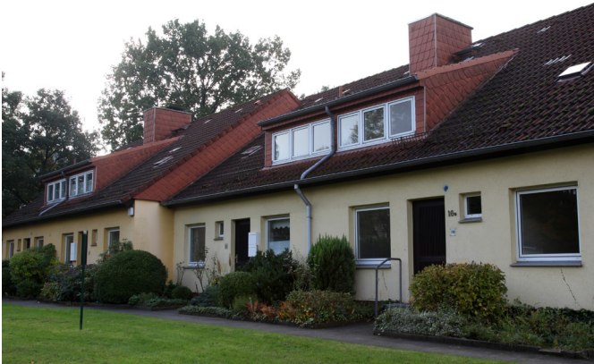
Anfang 2017 kommt der Abrissbagger.
