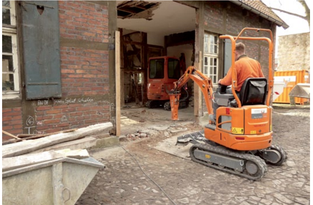
Der 1,15 t Bagger Takeuchi TB 210 R in der Burg Vischering im Sanierungseinsatz.
