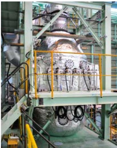
**Sauber.** Dank SCR-Katalysator sinkt der Stickoxid-Ausstoß um bis zu 85 Prozent.
