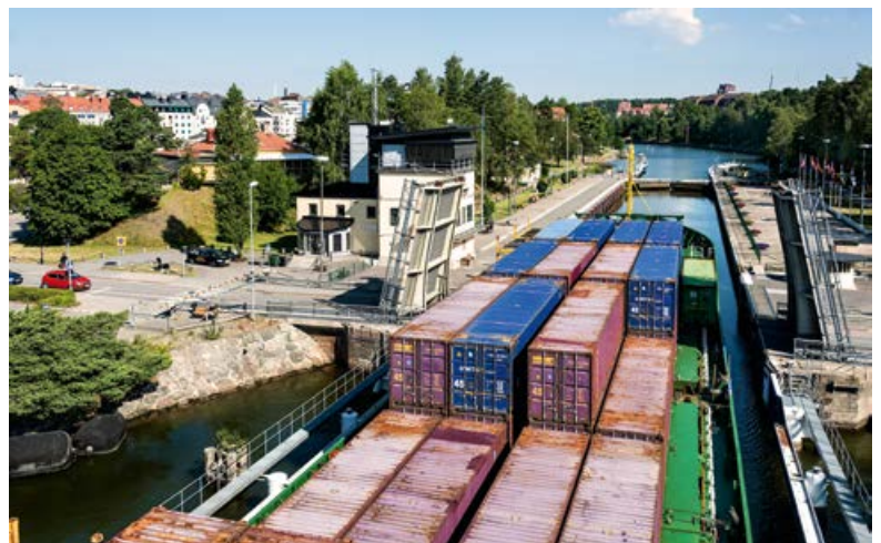
Engstelle. Einfahrt mit geöffneter Straßenbrücke in eine Schleuse beim Södertälje-Fjord.
