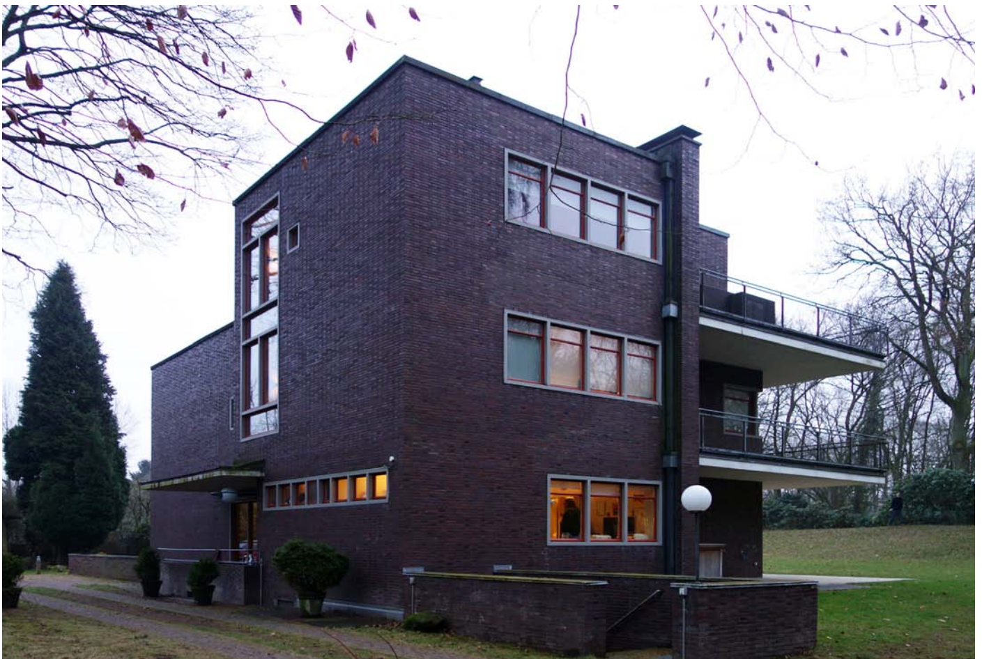
Bild 11: Eingangsfassade Haus Müller Drenkberg, 2017
