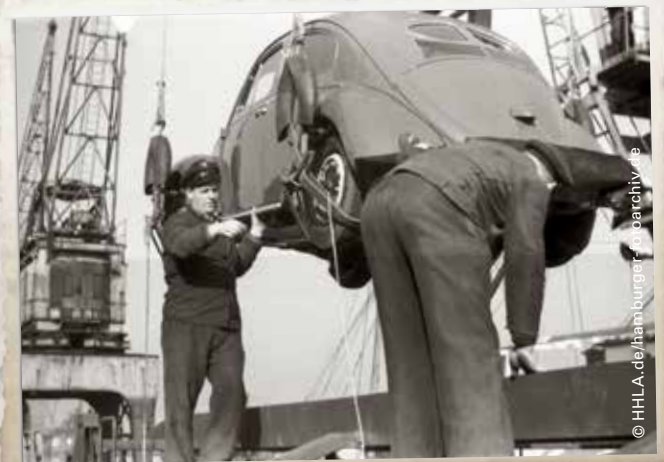
Autoverladung vor Zeiten der RoRo-Fähren: Hafenarbeiter sichern einen Käfer, der vom Güterwaggon in den Laderaum gehievt wird
