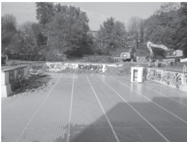
Abriss des Freibades Ohlsdorf. Im Hintergrund das ehemalige Umkleidegebäude. Foto: Harald Meyer, November 2015.
