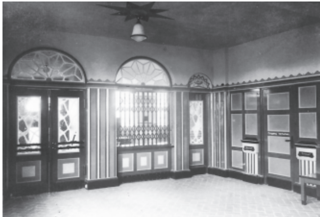
Eingangstür des Postamtes Fuhlsbüttel vom Schalterraum aus gesehen, 1926. Foto: Sammlung Hans-Kai Möller.
