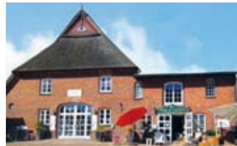
Haus & Garten Ambiente im Landhaus an der Osdorfer Landstraße 253
