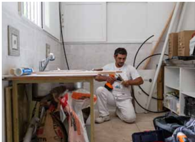
Die Gemeinschaftsküche wird gebaut
