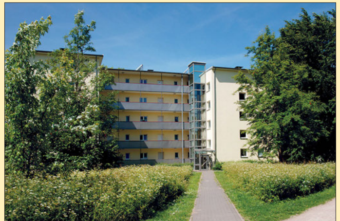
Sanierteres Punkthaus Bramfelder Weg 36 mit Laubengängen und Aufzug (Punkthaus: Einzeln stehendes Hochhaus, bei dem alle Wohnungen von einem zentralen, Treppenhaus und Aufzug enthaltenden Raum ausgehen).
