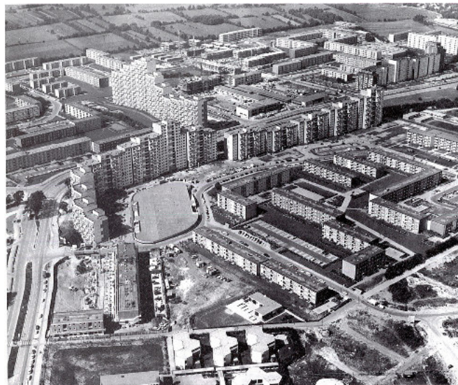
Die autogerechte Stadt · Foto: Baubehörde Hamburg
