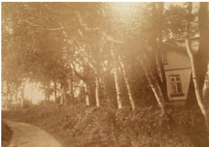
Rechts das Altenteilerhaus des Hinschen-Hofs, links der Maiwiesenredder Richtung Winterhude Foto: Slg. Schultz
