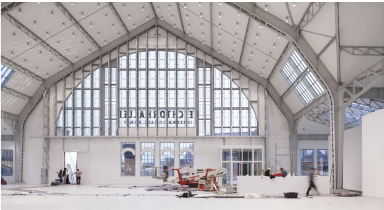
Die Hallen während der letzten Sanierungs- und Modernisierungsarbeiten. Foto: Henning Rogge.
