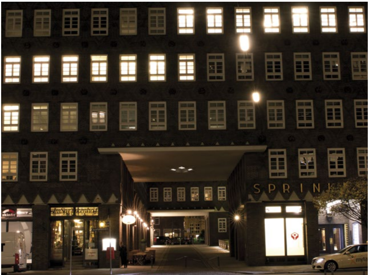
Ein Teil der monumentalen Sprinkenhof-Fassade mit ihren über 200 Fenstern. Das Gebäude, bisher im Eigentum der Allianz Real Estate, hat mit dem Patrizia-Fonds einen neuen Eigentümer gefunden. Foto: Sven Cassellius.
