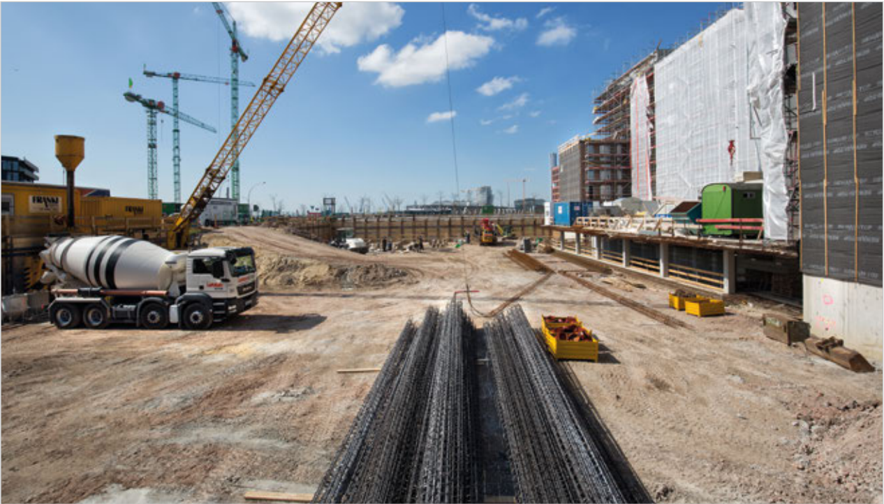
Die Bauarbeiten haben begonnen: Baustelle Am Lohsepark/Shanghaiallee.
