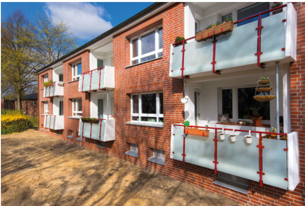
Ansicht der energetisch modernisierten Fassade im Lüttmelland
