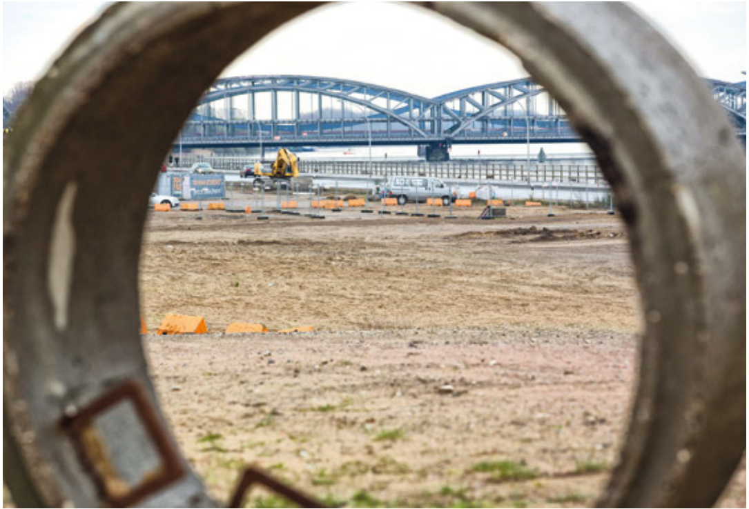
Blick auf das Baufeld VE 85, Baakenhafen
