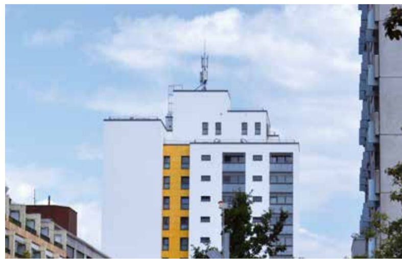
Frisch saniert: der erste von drei Wohntürmen der SAGA GWG in Mümmelmannsberg
