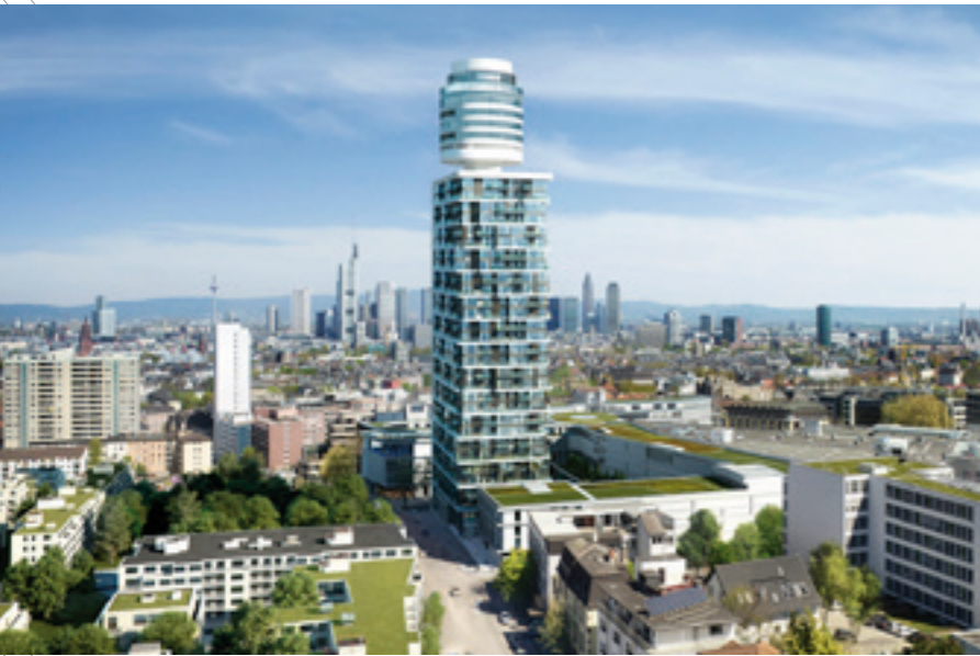
Die D+H Mechatronic AG sorgt weltweit für frische Luft in Gebäuden (links) Actris Henninger Turm GmbH & Co. KG, Frankfurt
