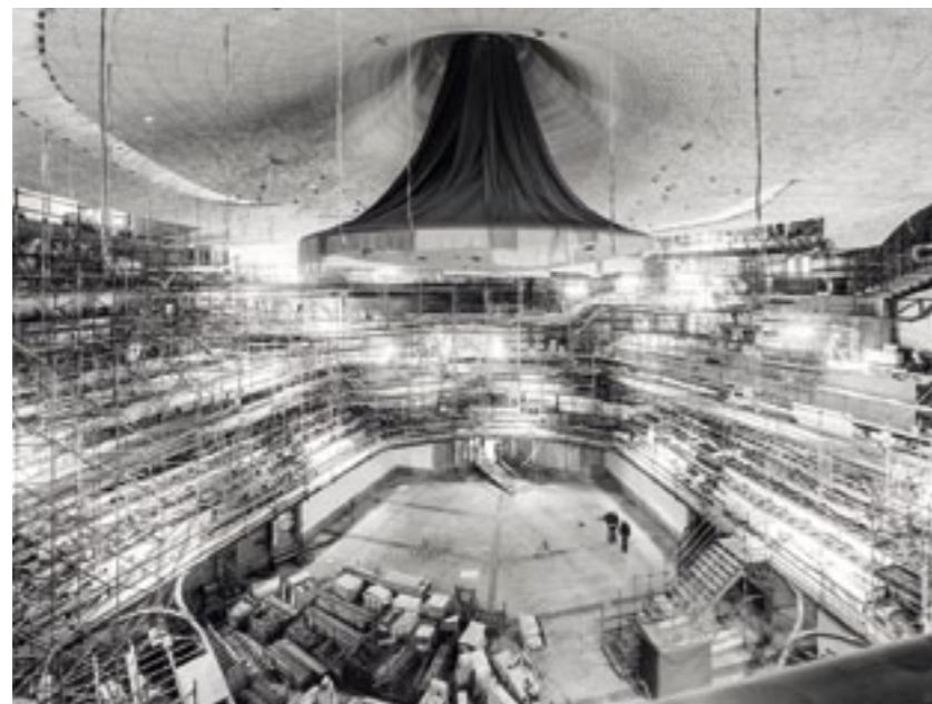
Der Große Saal der Elbphilharmonie im Bau
