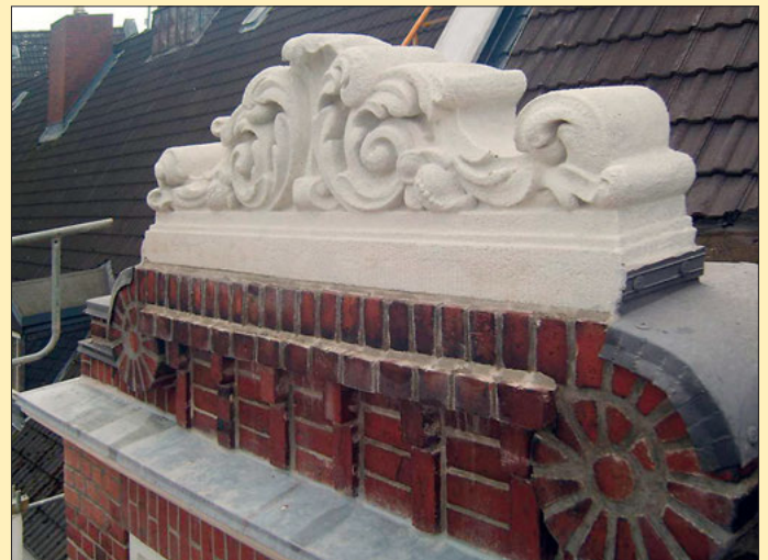
Ornamentale Ziergiebel über den Dachfenstern.
