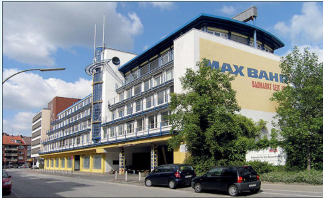
Das leer stehende Verwaltungs- und Verkaufsbauwerk der Baumarktkette Max Bahr im Mai 2014.
